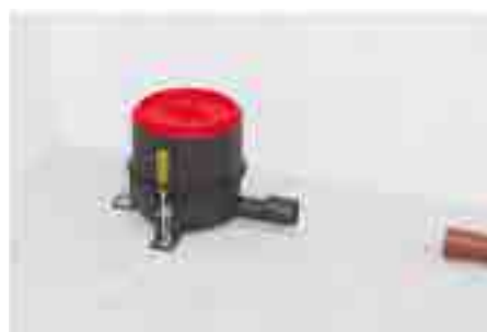
5. Fissare il corpo di scarico al fondo grezzo e regolare gli angoli.
