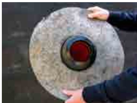
2. Applicare collare bituminoso
